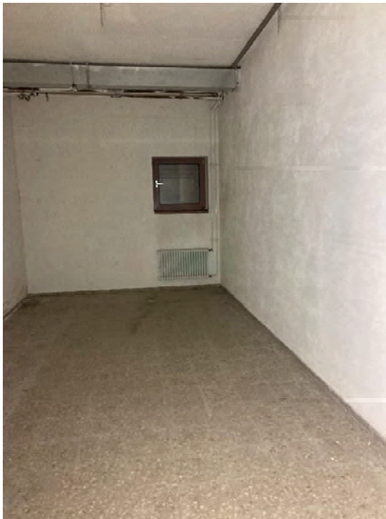
Abbildung 11: AVF 5-südlicher Bereich, Lagerräume
