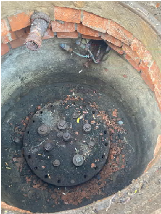
Abbildung 8: AVF 2, geöffneter Schachtdeckel 15.000 I-Tank
