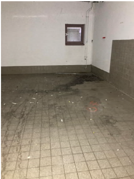
Abbildung 12: AVF 5-südlicher Bereich, Lagerräume
