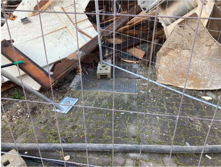
Abbildung 1: AVF 1, Schachtdeckel 7.000 I-Tank
